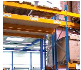
Sicherung eines Regaldurchgangs mit Holzplatten
